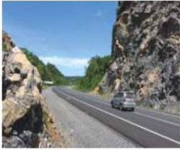
सड़क निर्माण हेतु पहाड़ों की कटाई
