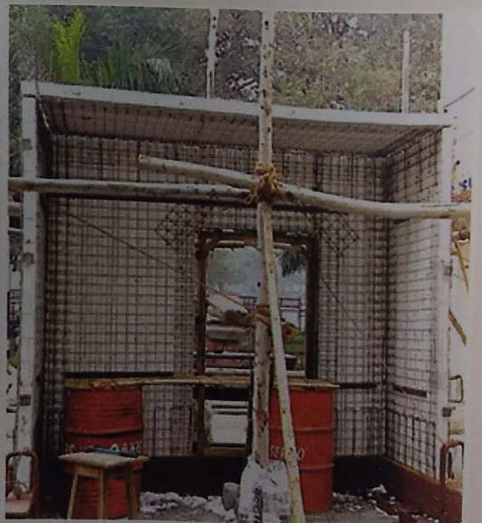
फैक्ट्री निर्मित ईपीएस कोर पैनेल से बना इमारत का ढांचा
