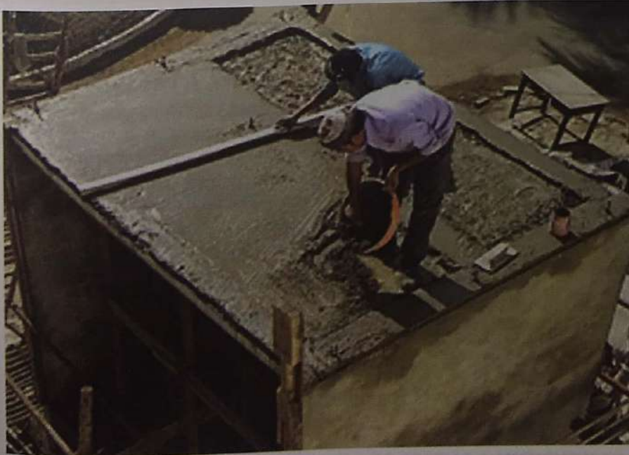
ईपीएस वाले कोर ढांचे और तैयार हो चुके इमारत के मॉडल पर कंक्रीट डालना
